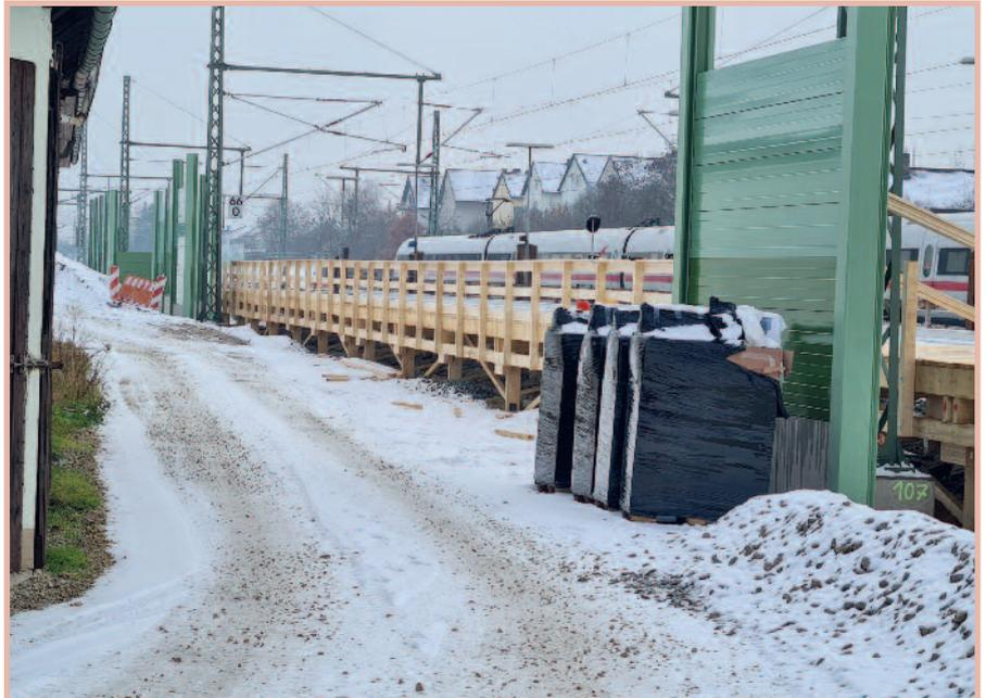
*Im Januar erfolgen im Bereich des Bahnhofs Bauarbeiten zum viergleisigen Gleisusbau sowie Arbeiten im Erdbau und Kabeltiefbau.*
